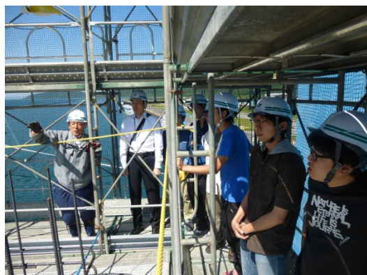
足場に登りケーソン制作現場を見学
