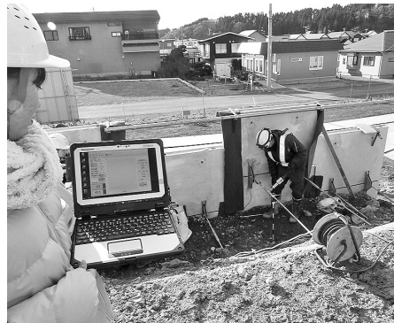
ターンバックルのトルク履歴が瞬時にPCへ転送される
